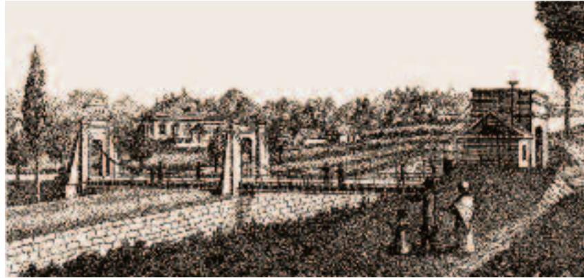
Drahtbrücke von Pâquis in Genf, eine der ersten Hängebrücken Europas
