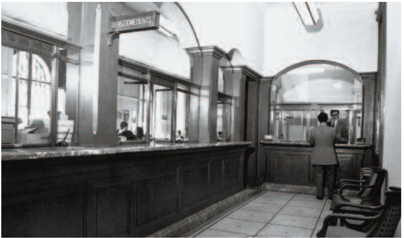
Die Hauptschalterhalle der Bank in der Rue Diday Nr. 10
